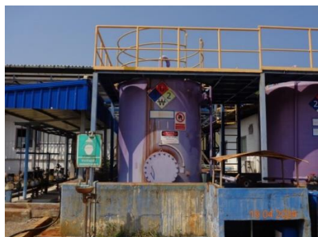
ภาพที่ 2-29 การสร้าง Bunding บริเวณพื้นที่ตั้งถังบรรจุน้ำมันที่เป็นของเหลว
