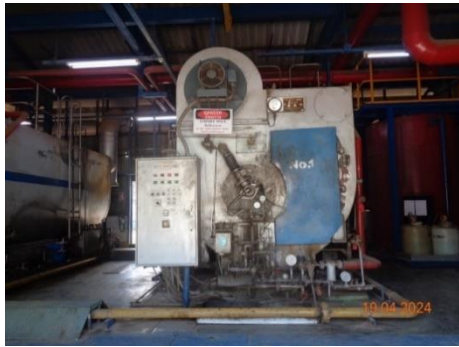
ภาพที่ 2-1 ระบบควบคุมกึ่งอัตโนมัติ เพื่อควบคุมส่วนผสมระหว่างอากาศและน้ำมันที่ Boiler
